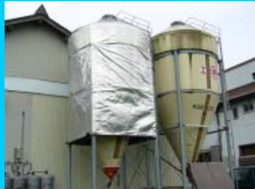
遮光カバーで覆った飼料タンク
