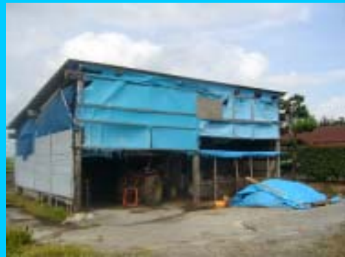
古電柱を再利用した堆肥舎
