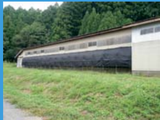
牛舎に設置した遮光ネット
