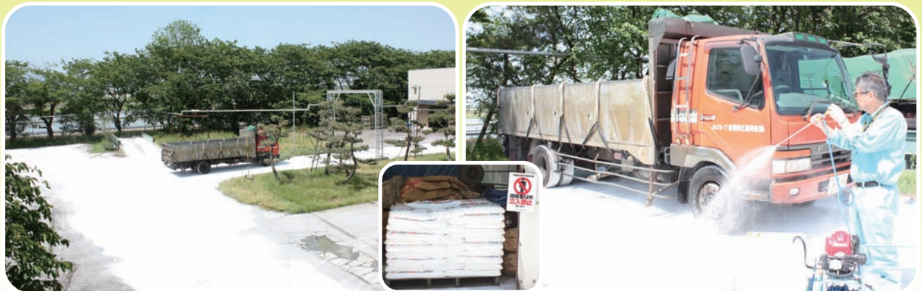
消石灰の散布状況
